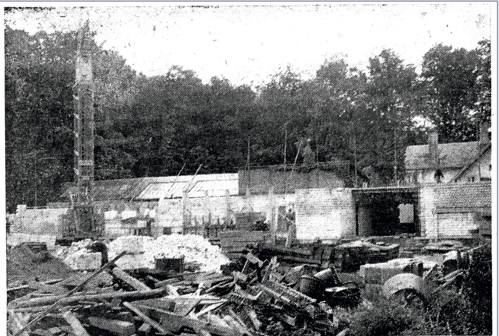
DER ERSTE BAUABSCHNITT des Verwaltungsgebäudes der Kassenärztlichen Vereinigung Schleswig-Holstein an der Ecke Eutiner Straße und Bismarckallee, das dreigeschossig gebaut wird, wurde begonnen. In etwa vier bis fünf Wochen soll mit dem zweigeschossigen Trakt für die Ärztekammer Schleswig-Holstein an der Bismarckallee begonnen werden. Nach Auskunft von Diplom-Ingenieur Gärtner, Architekt BDA, der den Entwurf geschaffen und die Bauleitung hat, soll das Richtfest Ende Oktober sein. Foto: hjw
